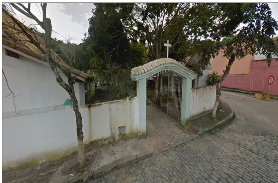
Figura 2: Entrada do Cemitério Pousada Eterna, Porto Seguro - BA.
